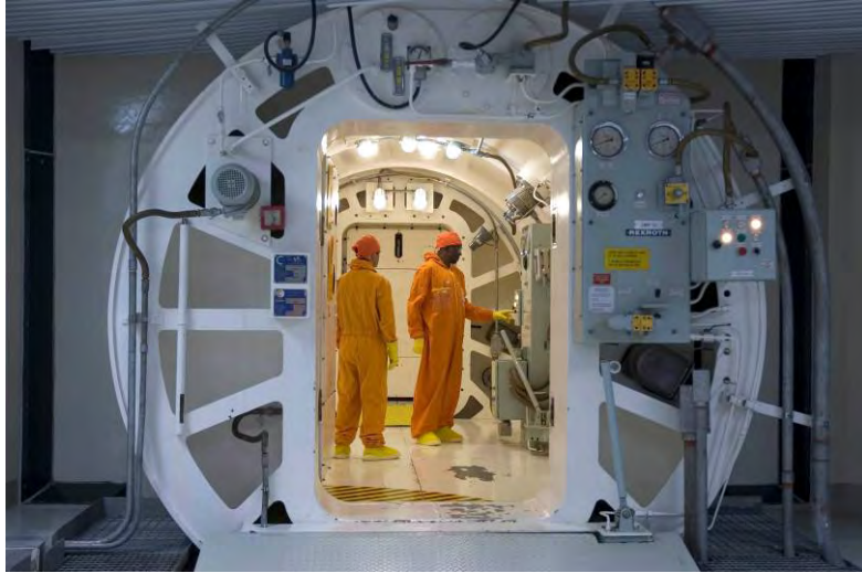
Técnicos em inspeção no edifício do reator de Angra 2
