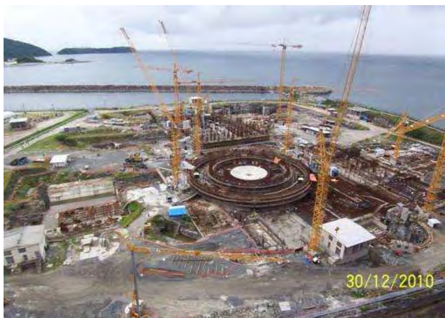
Status da construção de Angra 3 – Edifício do Reator
