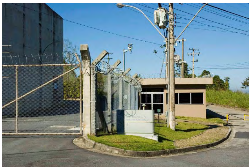
Depósito Intermediário de resíduos
